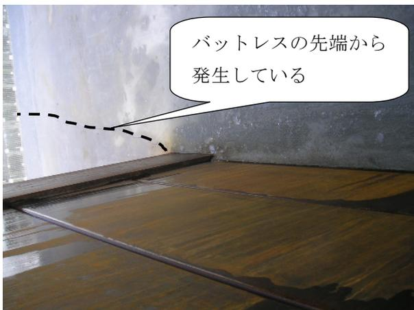
写真-1 上下流方向のひび割れ
