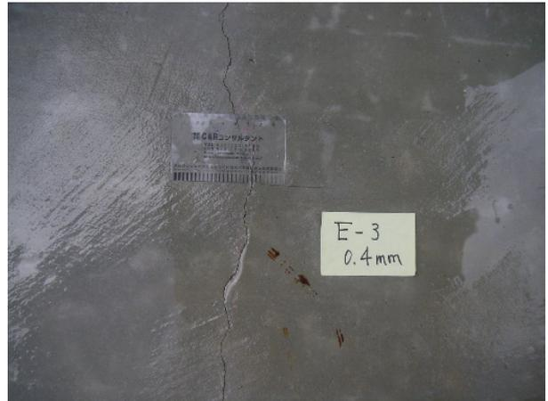
写真-2 ダム軸方向のひび割れ
